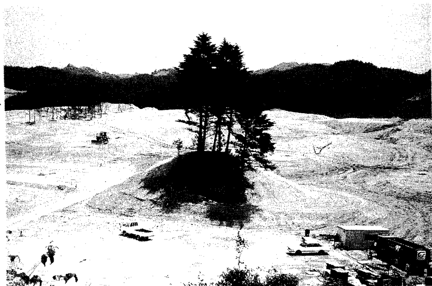
図4 Hゴルフクラブのコース造成風景、ゴルフ場の造成は設計にしたがって大規模な切り土、盛り土が行われる。
