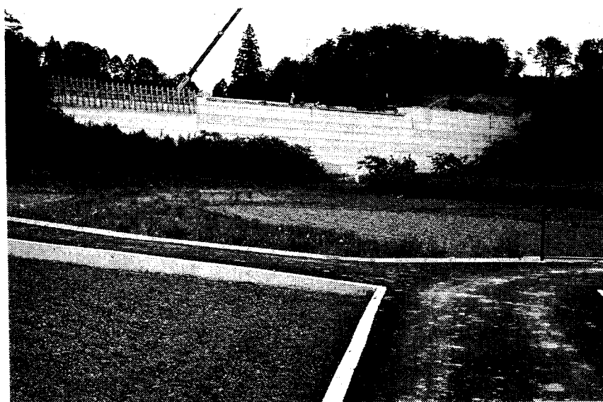
図3 Rゴルフ場造成によって谷合い前面に建設された砂防堤、砂防堤下部はコンクリート水路施設や道路整備も行われていた。
